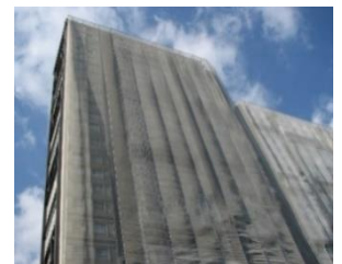
大規模修繕中の マンション
