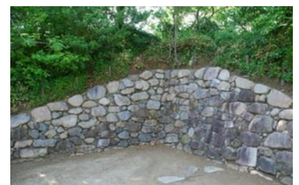
発掘された有岡城遺構
